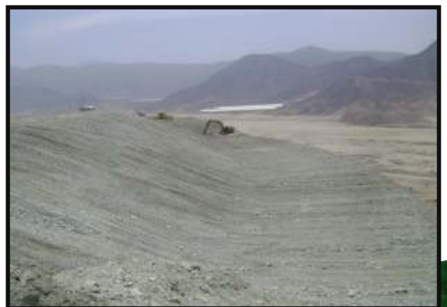
Mediante el uso de Excavadora sobre oruga y Bulldoser, se realizo la conformacion del talud para la ampliacion de la desmontera Condestable.
