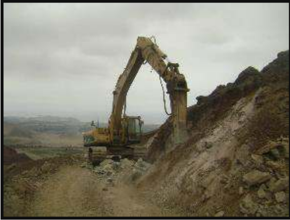
Ampliación de Vías con Excavadora sobre oruga CAT 330 CL, uso de martillo Neumático para conformación de berma a lo largo del camino.
