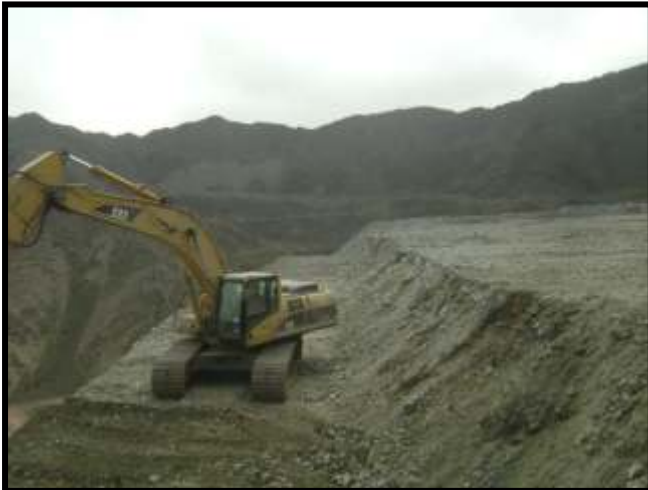
Mediante el uso de Excavadora sobre oruga y Bulldoser, se realizo la conformacion del talud para la ampliacion de la desmontera Condestable.
