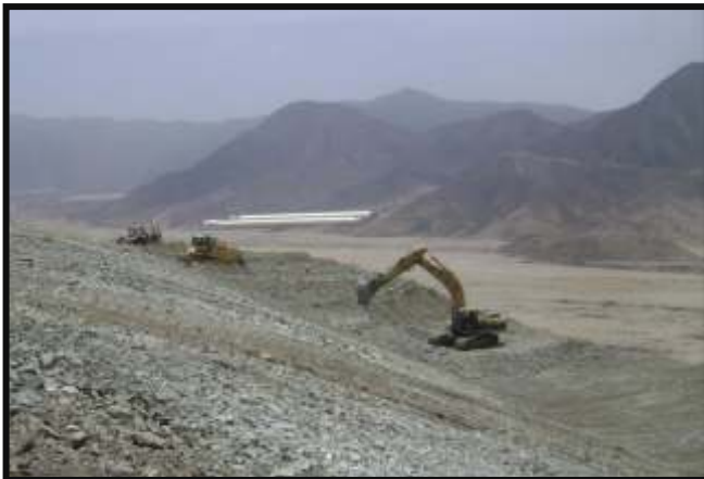
Mediante el uso de Excavadora sobre oruga y Bulldoser, se realizo la conformacion del talud para la ampliacion de la desmontera Condestable.
