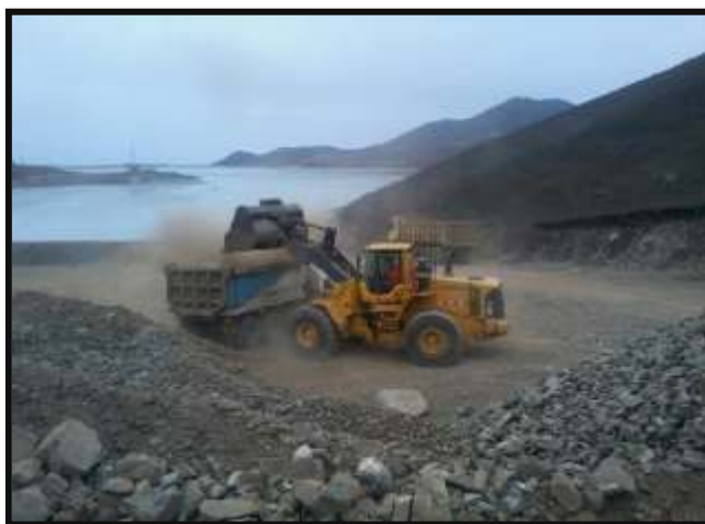
Conformación de Dique; mediante el uso de Cargador frontal y volquetes Volvo FMX,FM y Mercedes Benz
